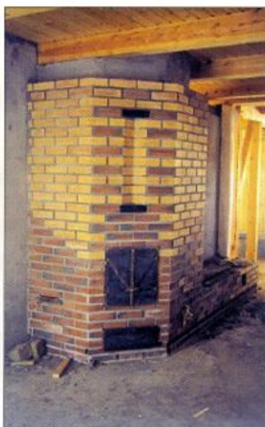
Masseovnen sett fra stua. Ovnen og sittebenk er murt i to forskjellige teglstein, mens askeskuff og luke til brennkammer er i stål.
